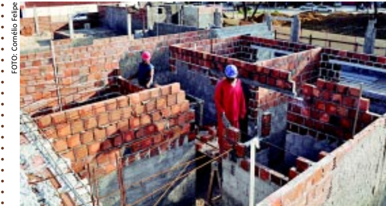
[FOTO&LEGENDA] Estão em processo avançado as obras do Centro de Práticas Integradas e Complementares, que está sendo construído com recursos próprios da Prefeitura de João Pessoa. O imóvel, localizado nos Bancários, tem investimento superior a R$ 1,4 milhão.
